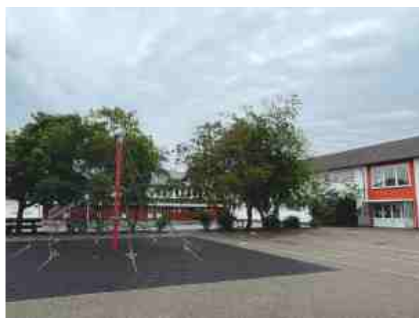
Grundschule in Oppenwehe
