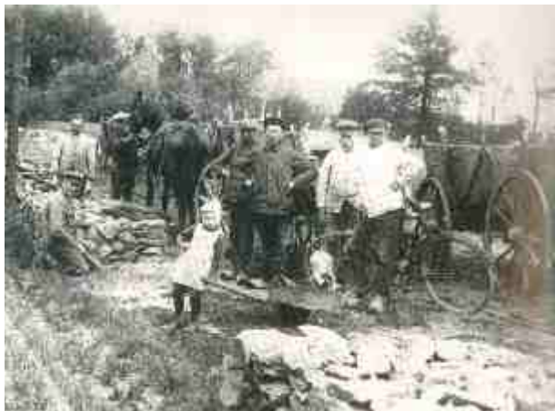
Straßenbau im Hand- und Spanndienst, Twiehausen, 1928
