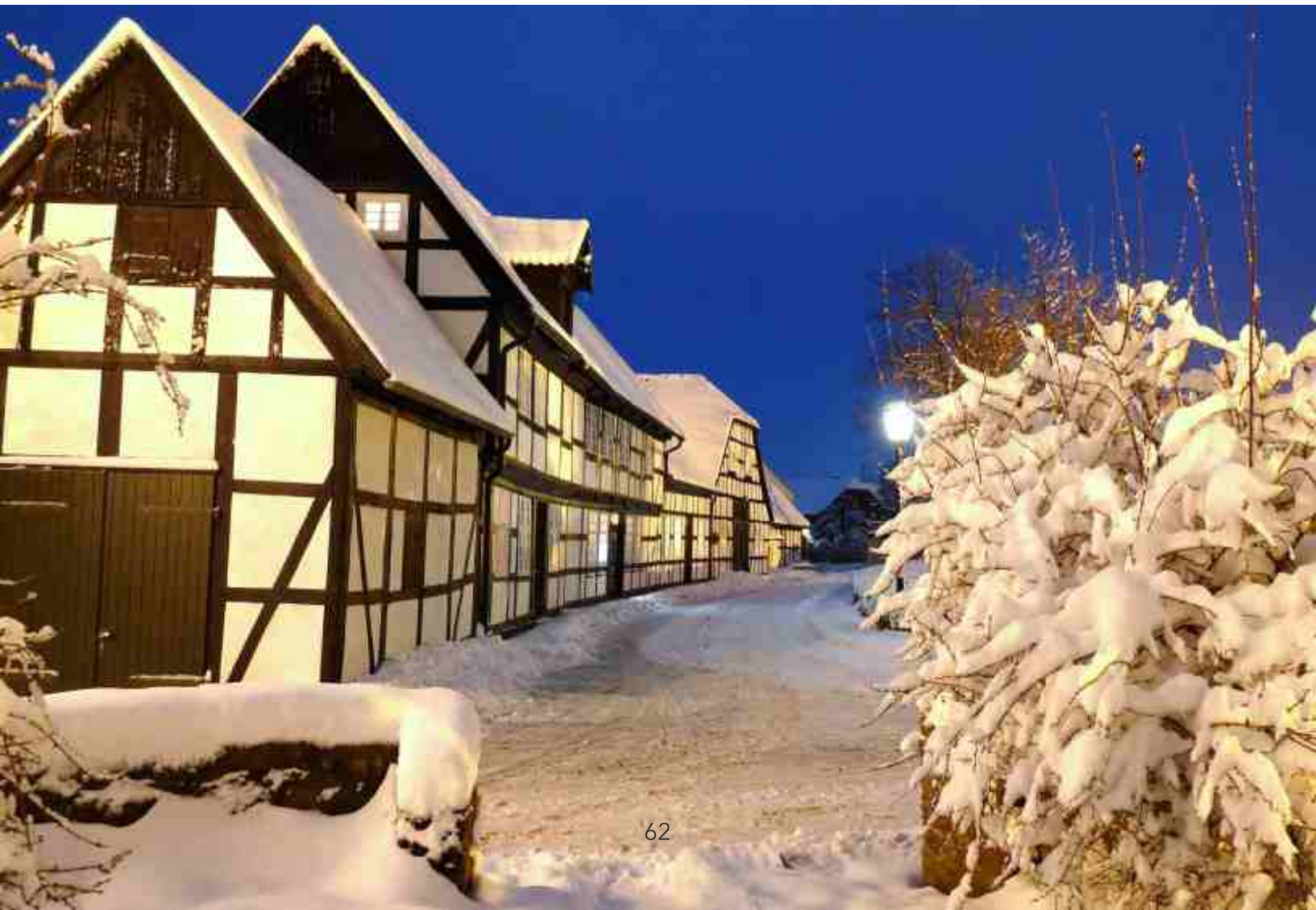
Historische Fachwerkhäuserfront in Levern
